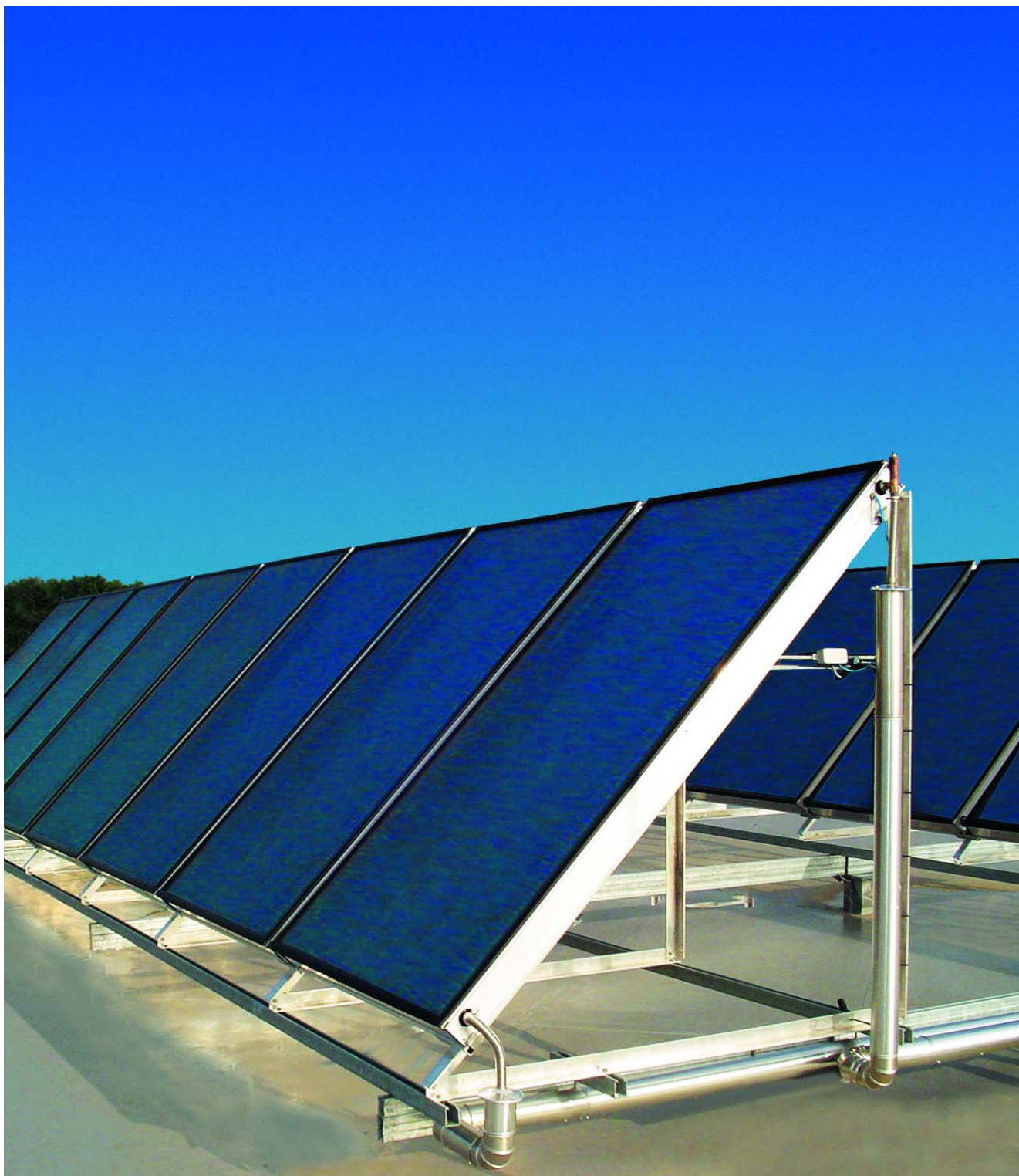
Lapos tetőre szerelt függőleges kollektor-berendezés nagy hőszükségletek kielégítéséhez
